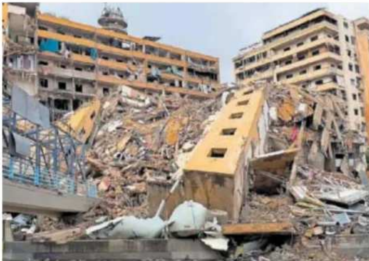
Un edificio destruido por Israel ayer en Beirut. H. MALLA (AP/LAPRESSE)
